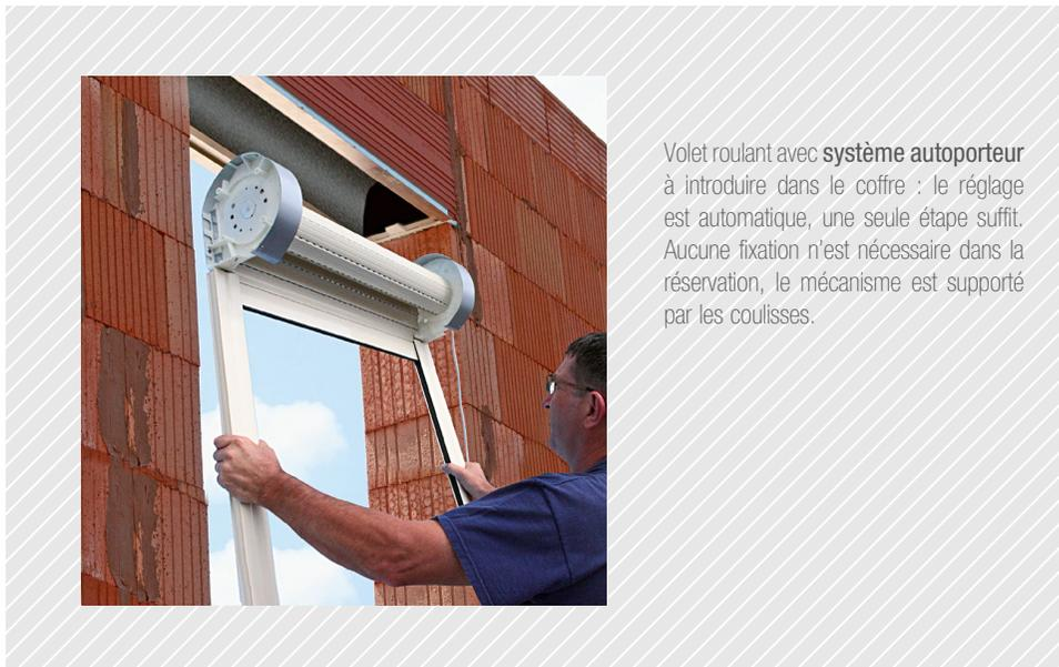
Volet roulant avec **système autoporteur** à introduire dans le coffre : le réglage est automatique, une seule étape suffit. Aucune fixation n'est nécessaire dans la réservation, le mécanisme est supporté par les coulisses.
